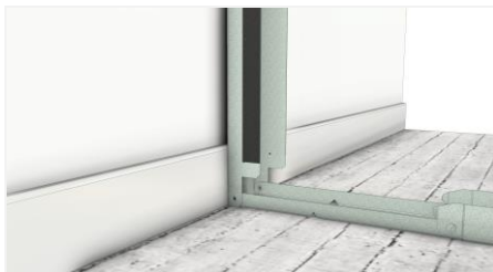
Plaats de C-module tegen de plint.
